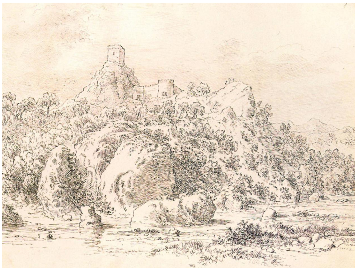
Ottavio Campedelli (1792-1862), «La rocca di Monte Leone e la Rocchetta Mattei a Grizzana Morandi», prima metà del XIX sec.: lo sperone di Savignano con la torre e le cortine della rocca medievale ancora in piedi, sul fiume ai suoi piedi — la stessa struttura rilevata dal Catasto, prima che Cesare Mattei vi edificasse la Rocchetta (dal 1850). Collezioni Fondazione Carisbo.
